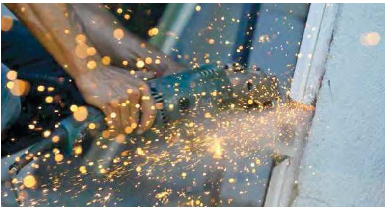
Rom që punon në instalimin e dritareve në Kumanovë.
